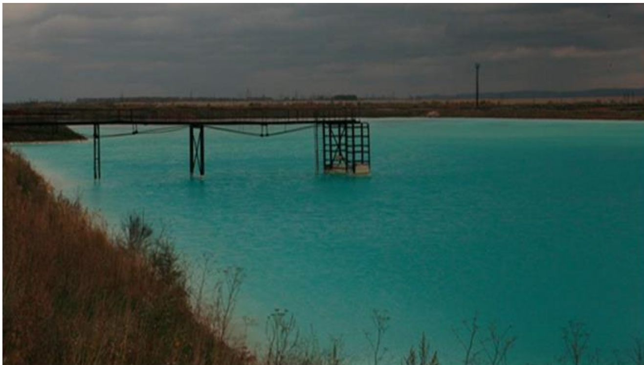
Рис. 14. Шахтный водосброс из карты N 3 в бассейн осветленной воды БГРЭС.
