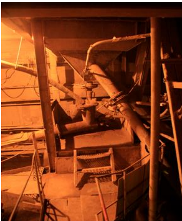
Рис.8.Золосмывные аппараты на входе в баки-мешалки резервной схемы ГЗУ электрофильтров (на блоках ст.NN1 и 2).
