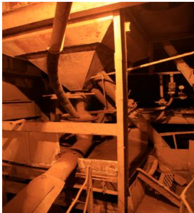
Рис.8.Золосмывные аппараты на входе в баки-мешалки резервной схемы ГЗУ электрофильтров (на блоках ст.NN1 и 2).
