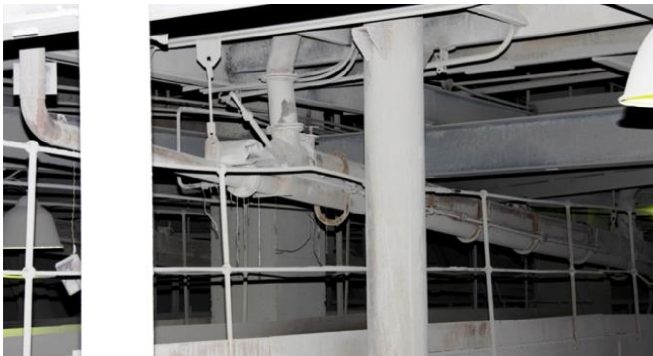
Рис.23. Аэрожелоба на блоке ст.Н4 Рефтинской ГРЭС (до внедрения высоконапорной системы ПЗУ).
