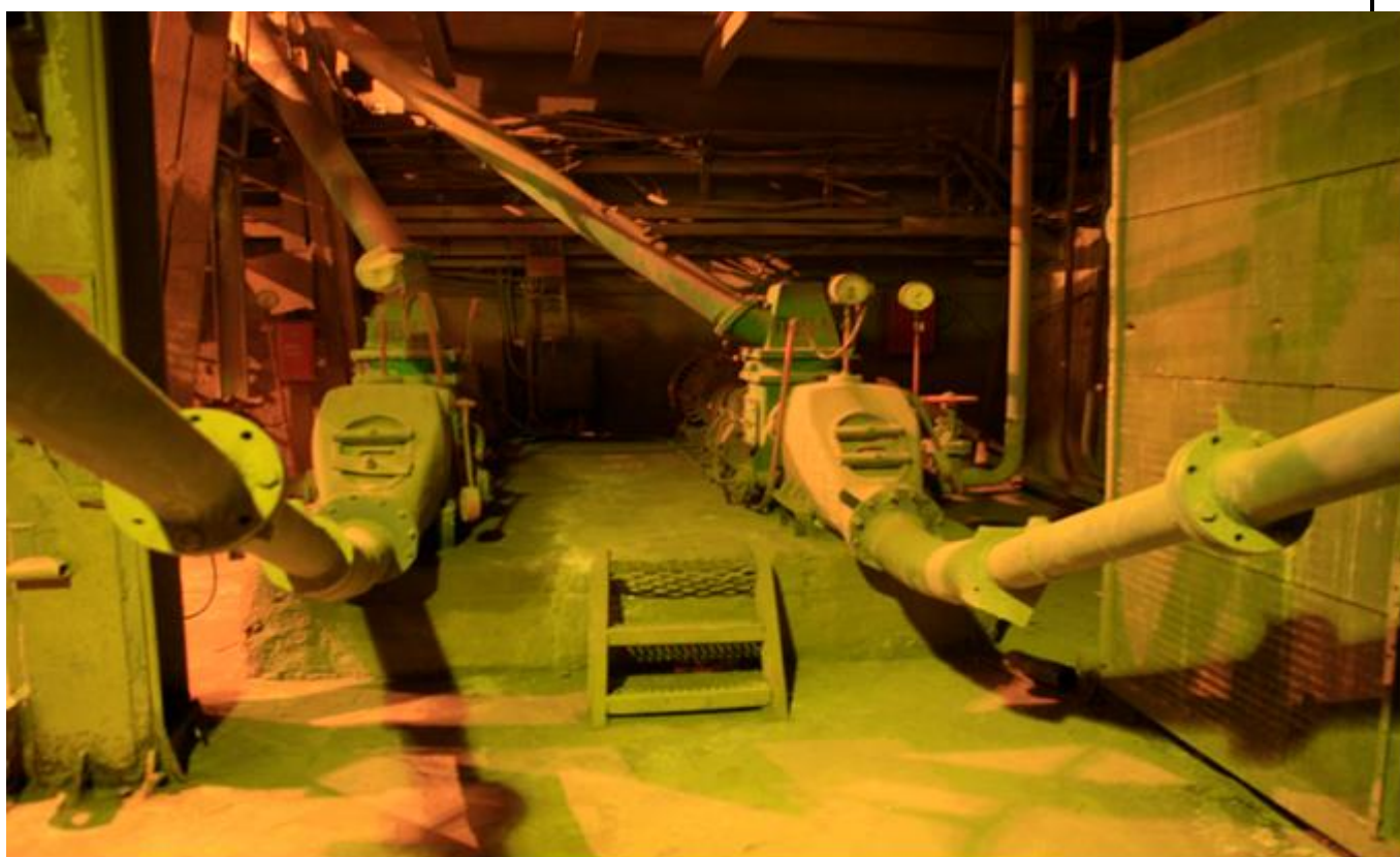
Рис.7.Пневмовинтовые насосы системы золоудаления БГРЭС. Под каждой осадительной станцией установлены золосмывные аппараты, подающие пульпу, в соотношении 1:12, в багерную насосную.
