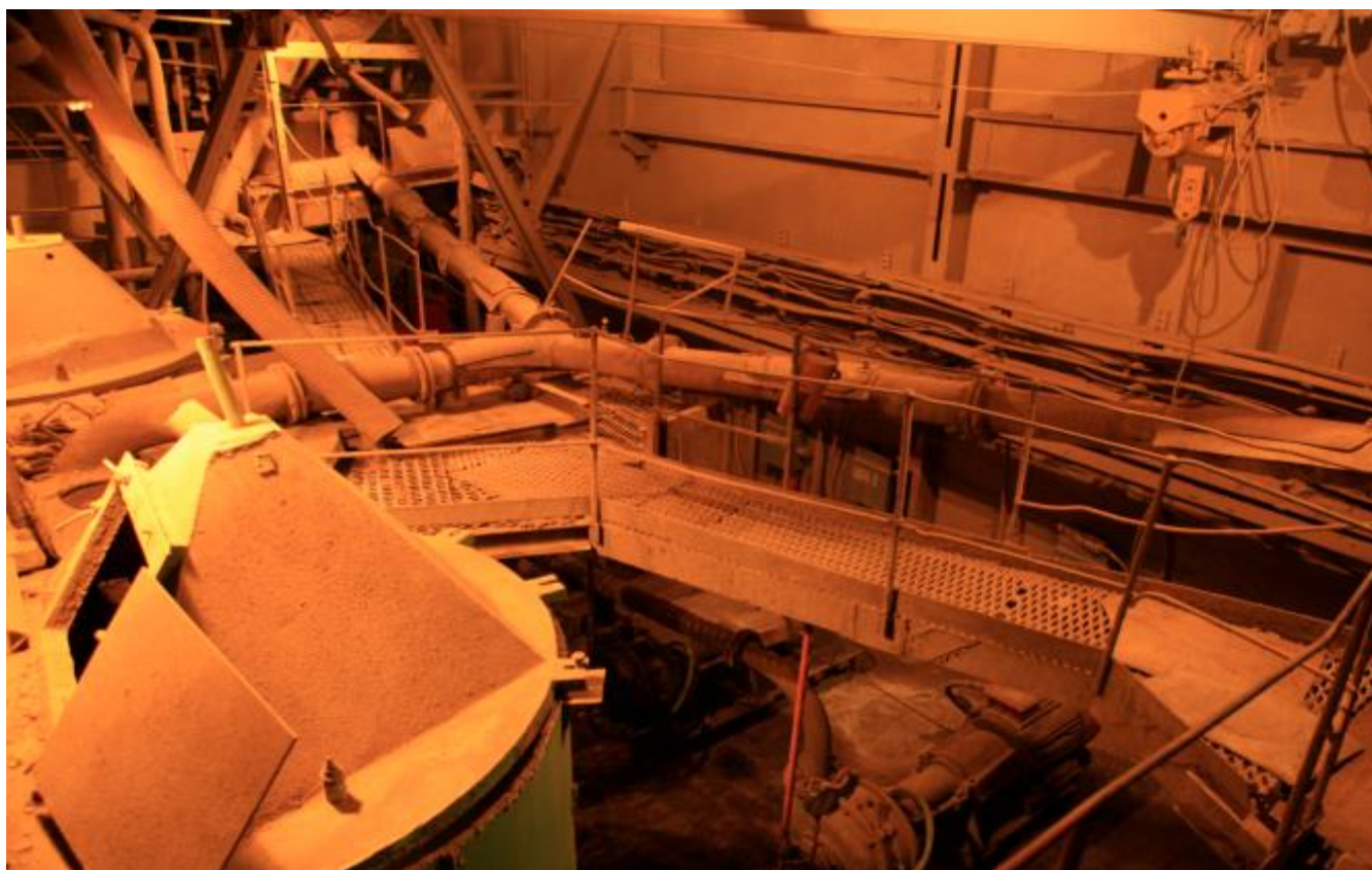
Рис.9. Узел приготовления пульпы резервной схемы ГЗУ электрофильтров (на блоках ст. NN1 и 2).
