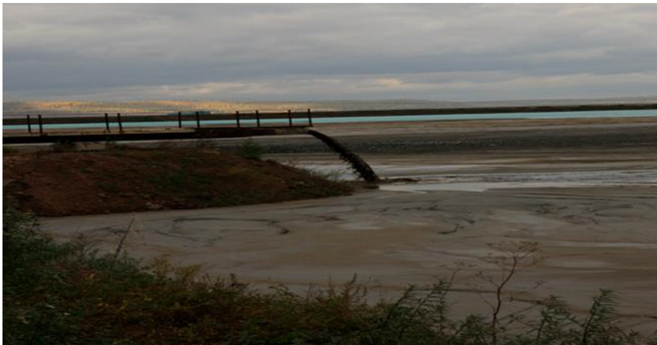
Рис.12. Вид на торцевой выпуск из разводящего золошлакопровода гидравлического золоотвала БГРЭС.
