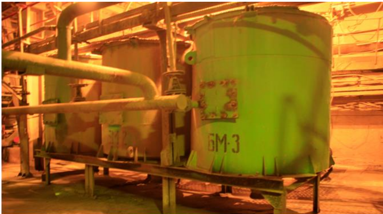
Рис.10. Смесители пульпы резервной схемы ГЗУ электрофильтров (на блоках ст. NN1 и 2).
