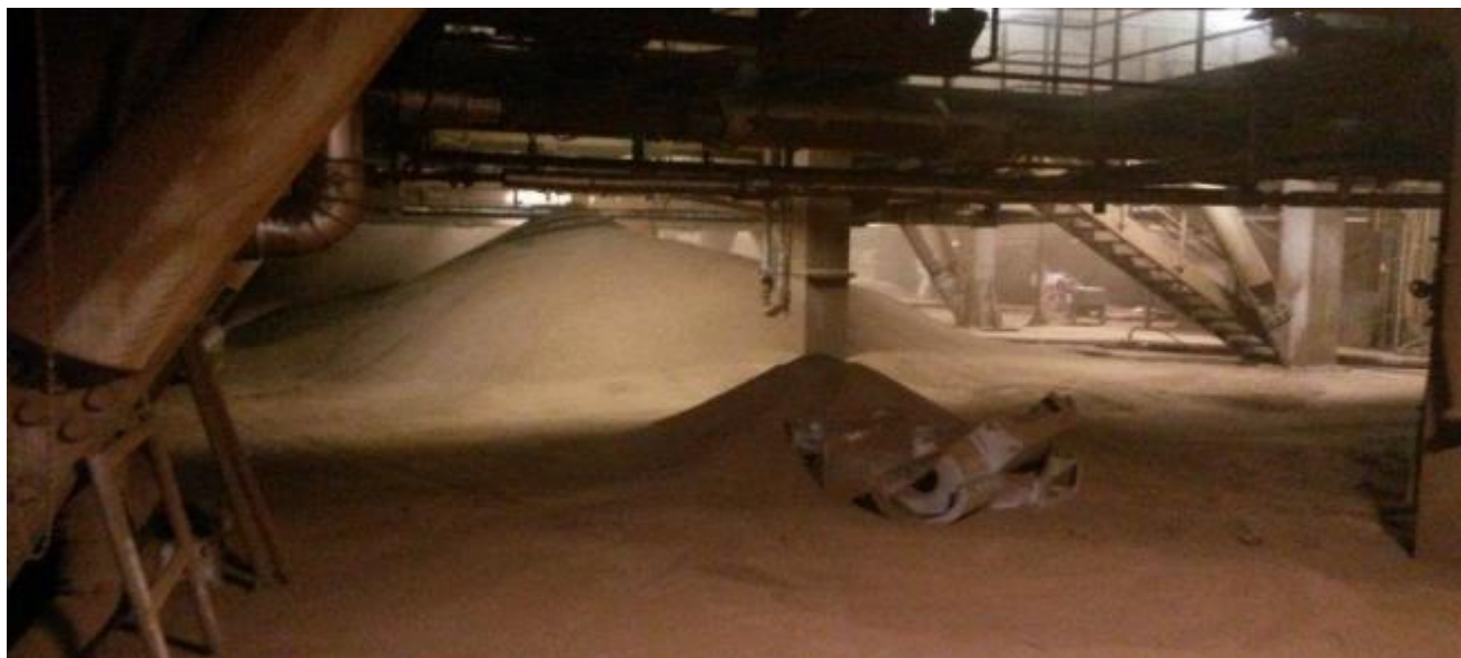
Рис. 27. Состояние подбункерного помещения электрофилтра Niederaußem, RWE Power AG блок «К», Нуст. =950 Мвт, при эксплуатации системы система «Fluidcon» (усовершенствованные аэрожелоба).
