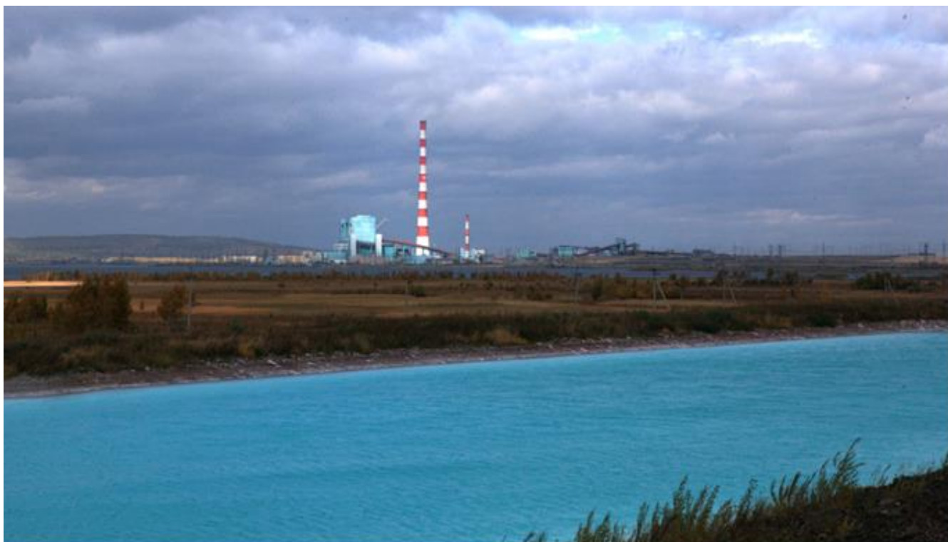
Рис.13. Бассейн осветленной воды системы гидрозолоудаления БГРЭС.
