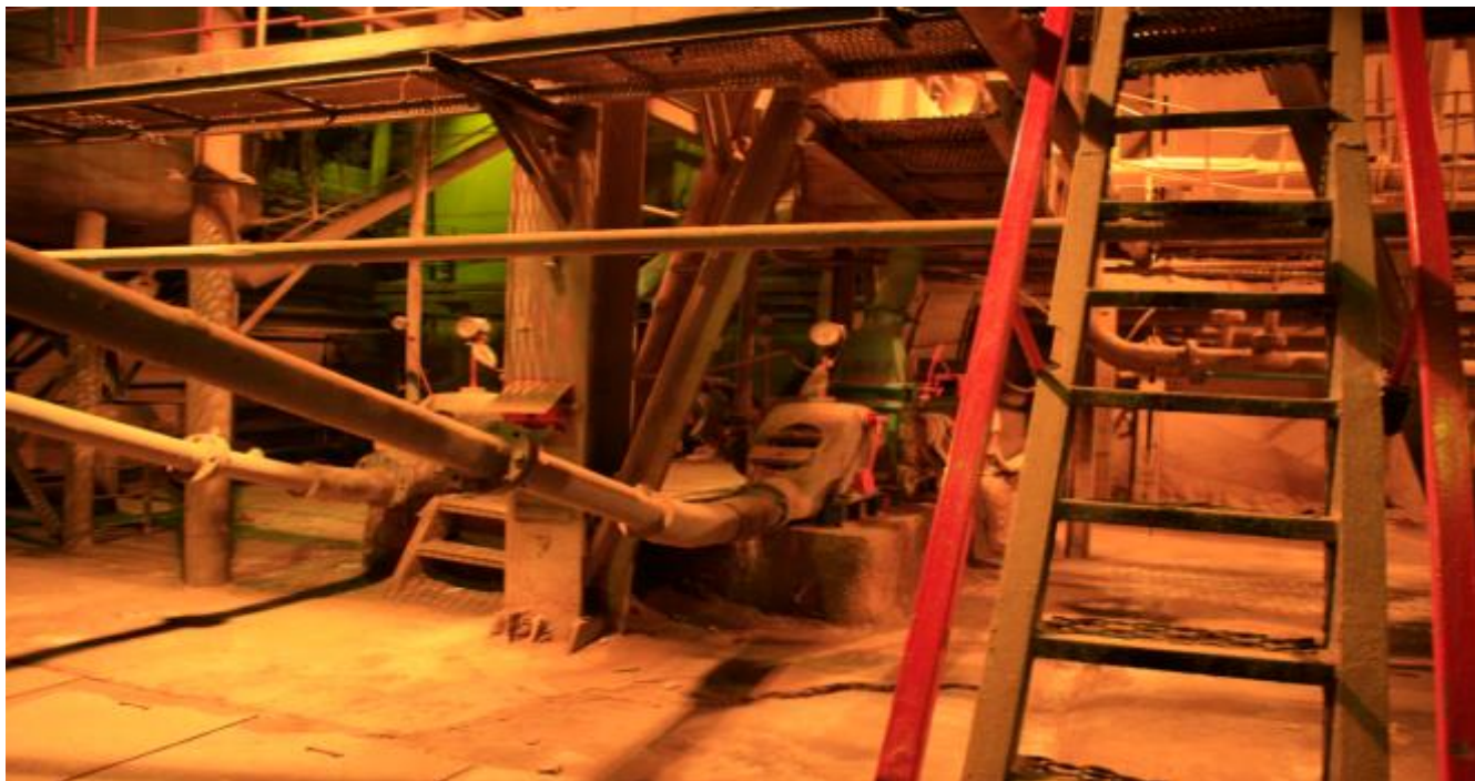
Рис.6.Пневмовинтовые насосы системы золоудаления БГРЭС
